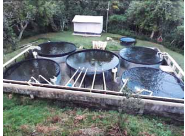
Figura 6. Batería de estanques circulares en geomembrana Fuente: Rafael Rosado P.
