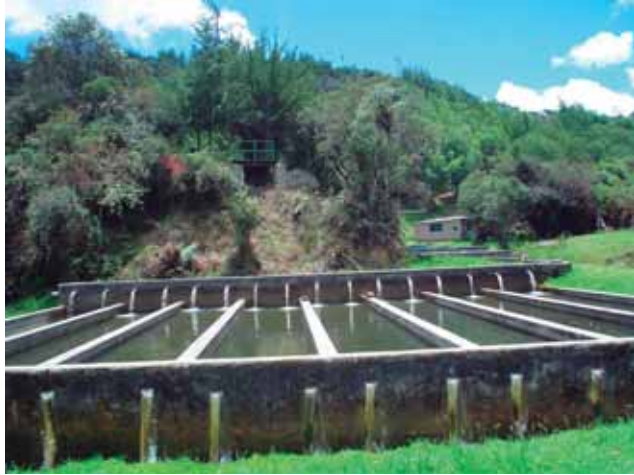
Figura 5. Batería de estanques rectangulares para engorde Fuente: Rafael Rosado P.
