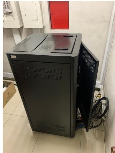
NC. Se incumple con la Políticas Específicas de Seguridad y Privacidad de la Información dado que, en los cuartos técnicos se evidencian elementos que no pertenecen a Tecnología, generando riesgos que puedan dañar el cableado instalado en los racks.
