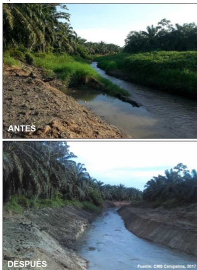
Figura 1. Mantenimiento en canales
