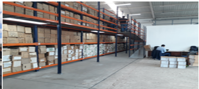
Foto: Mezzanine y estructura metálica.
