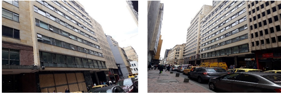
Fotografía 8: Fachada y Acceso principal edificio Bancol, detalles: acabados y pisos
