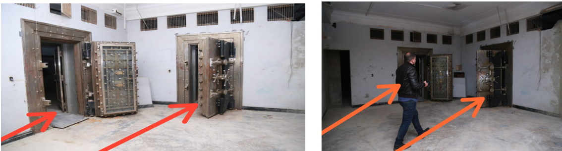
Fotografía 12: Detalle de las puertas de acceso al sótano
